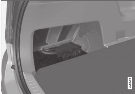
Die Startbatterie befindet sich im Kofferraum.
