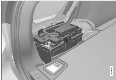
Die Startbatterie befindet sich im Kofferraum.
